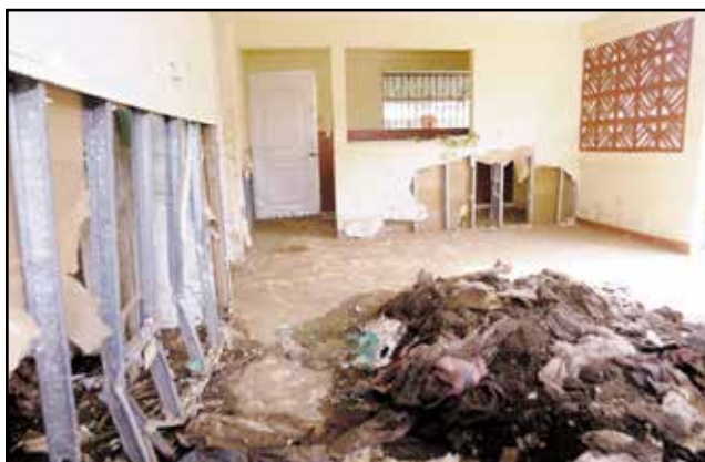
Casas de residenciales destruidas por lluvias
