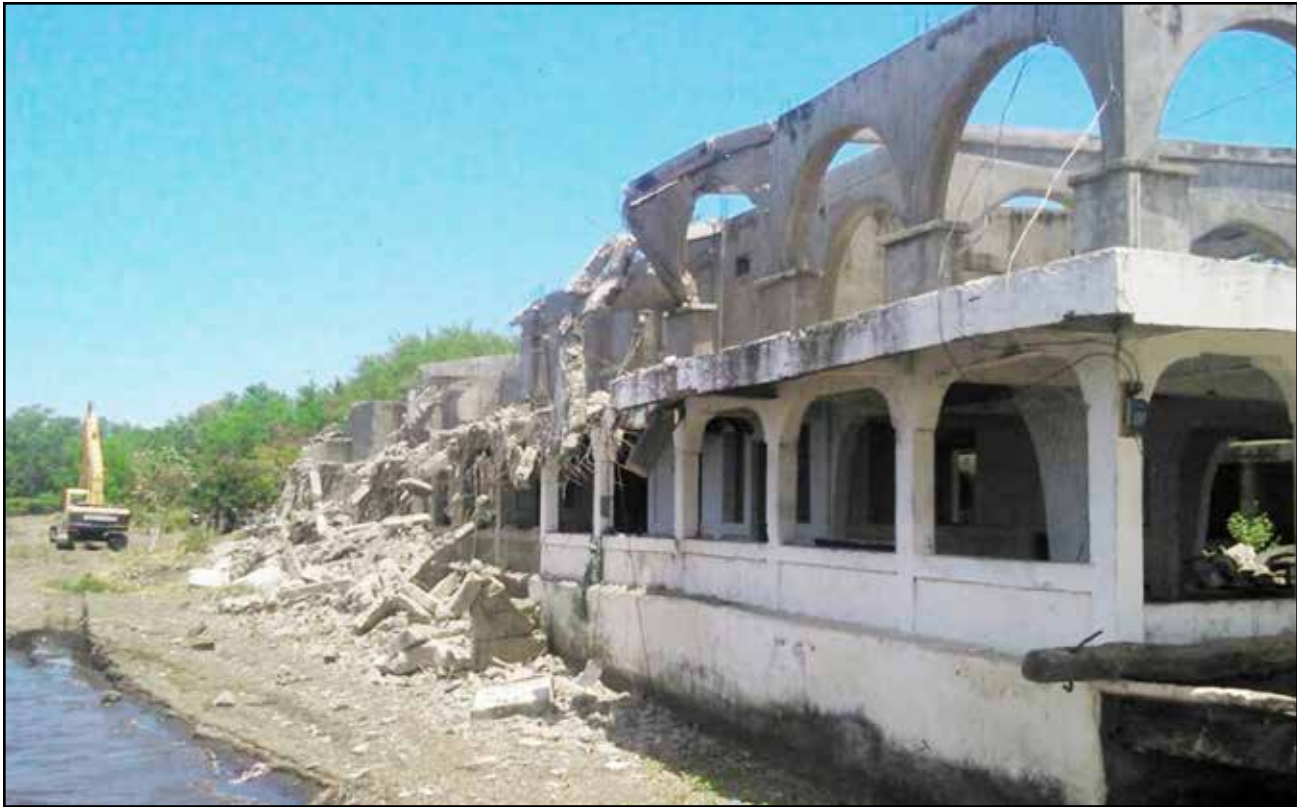
Demolición del hotel en construcción propiedad del empresario Milton Arcia.
